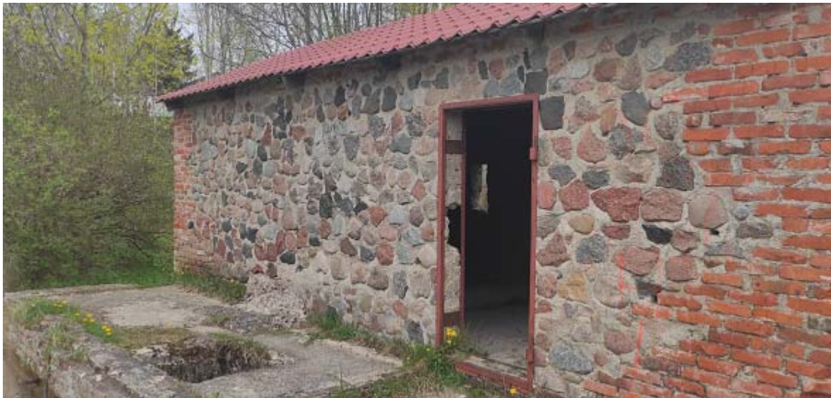
Рисунок 7 - Сохранившаяся часть здания над первым водяным колесом (фото автора, дата съемки 05.05.2022)
