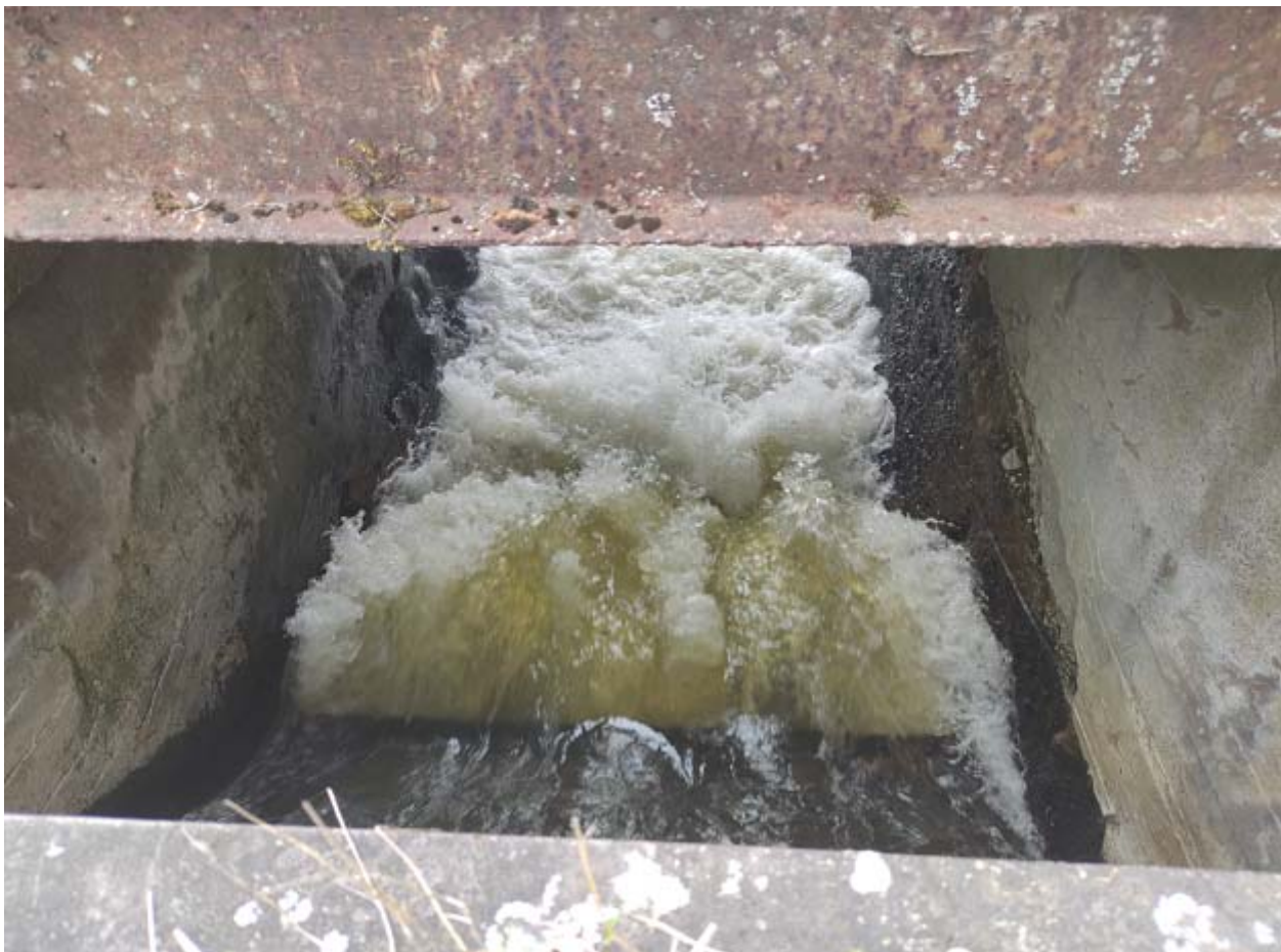
Рисунок 9 – Фрагмент внутренней части водостока (фото автора, дата съемки 05.05.2022)
