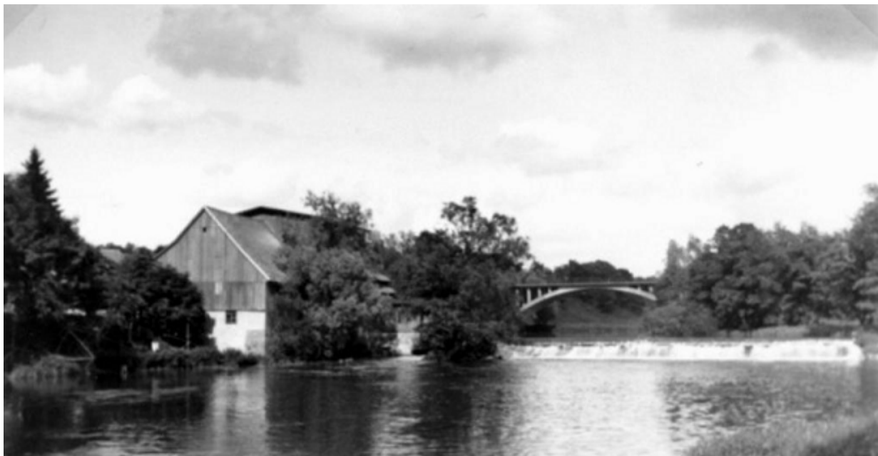
Рисунок 3 – Гидроэлектростанция Гервишкемен. 1928-1932 г.(фото из источника [5])
