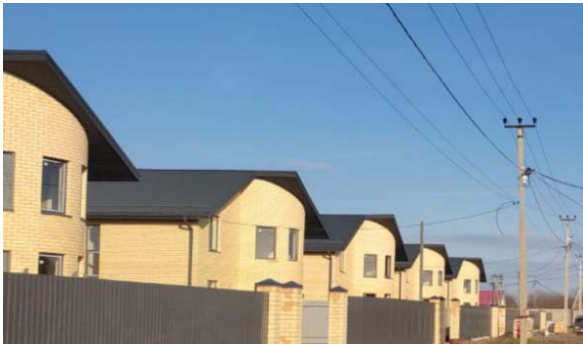
Рисунок 4 — Коттеджный поселок в Республике Адыгея, оборудованный электрическими котлами «Ардерия»
