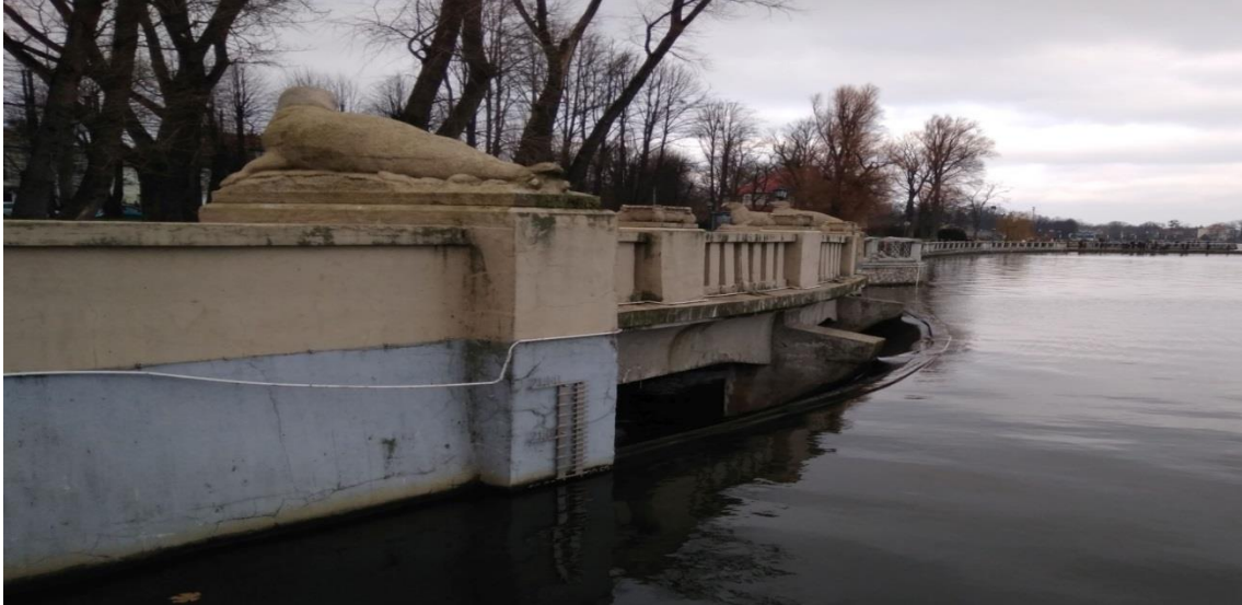
Рисунок 1 – Водозаборное сооружение на ручье Парковом (пруд Верхний). Фото авторов
