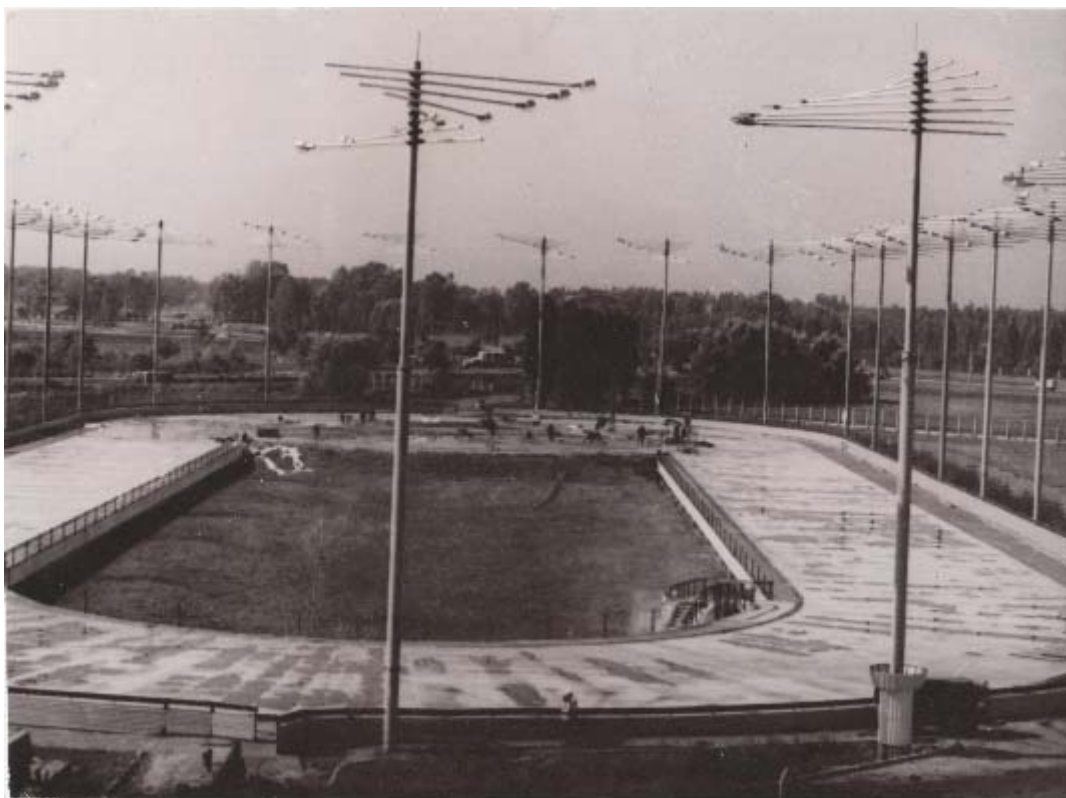
Рисунок 1 – Всепогодный ледовый стадион в Москве у метро «Водный стадион», построенный к Олимпиаде-60 из бетона нового поколения – ГСБ, 1973
