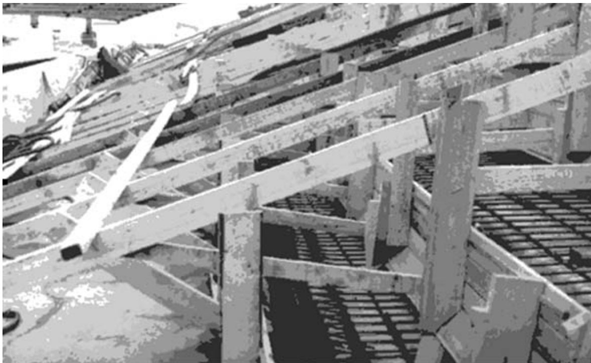
Рисунок 5 – Подготовка к бетонированию северной трибуны БСА «Динамо», июнь 1977
