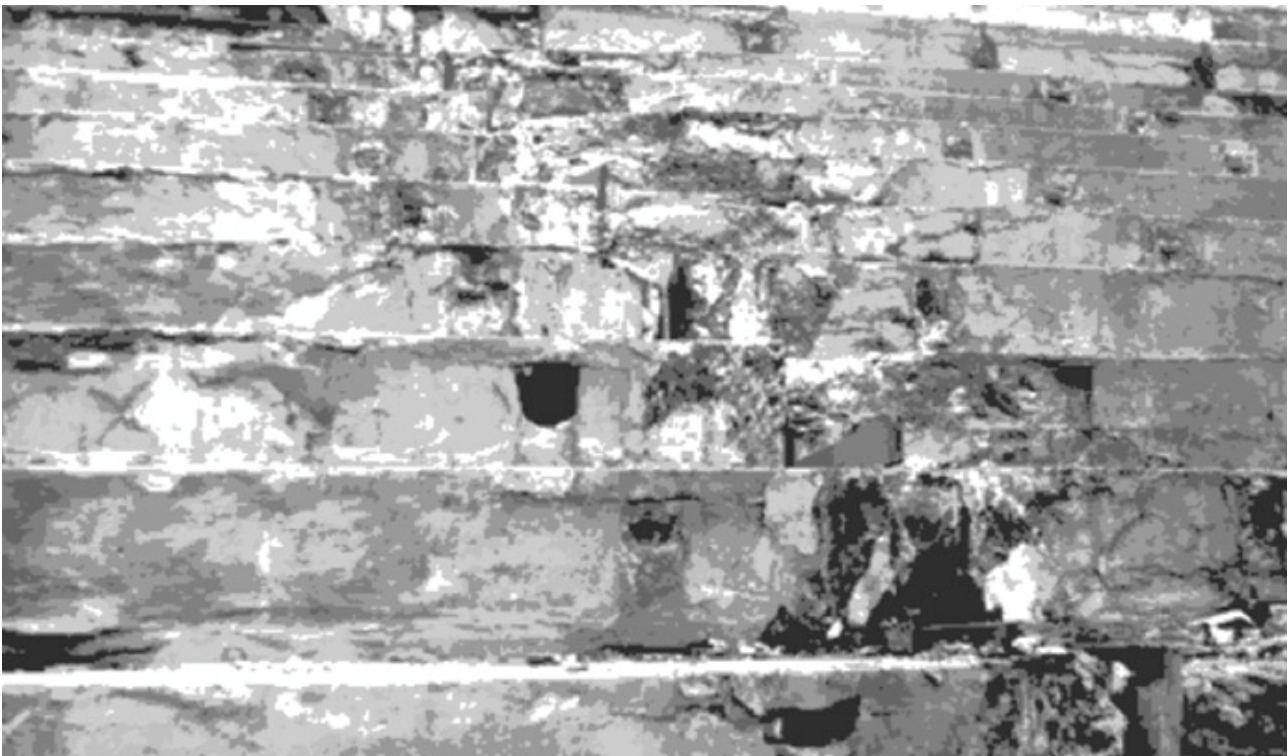
Рисунок 4 – Дефектный бетон трибун Большой спортивной арены (БСА) московского стадиона «Динамо», построенной в 1928. Начало ремонта и восстановления, 1977
