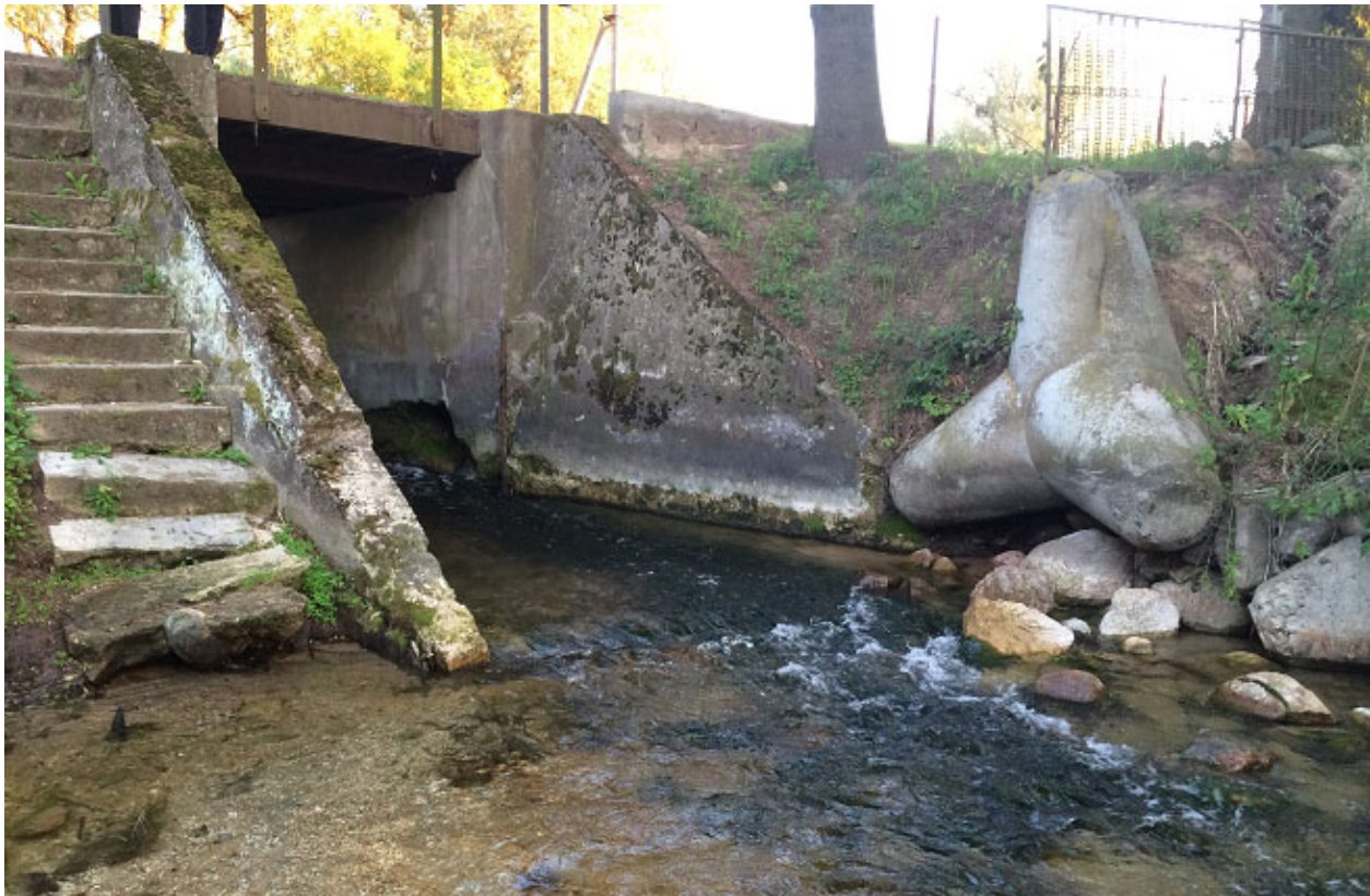
Рисунок 3 – Шлюз-регулятор со стороны нижнего бьефа
