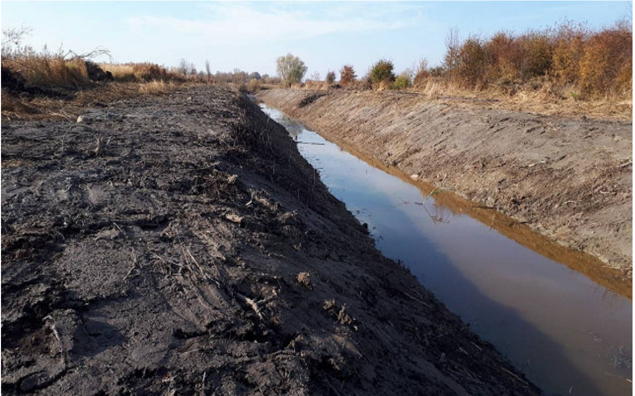
Рисунок 5 – Участок канала ТЖ-17 с кавальером на одном берегу
