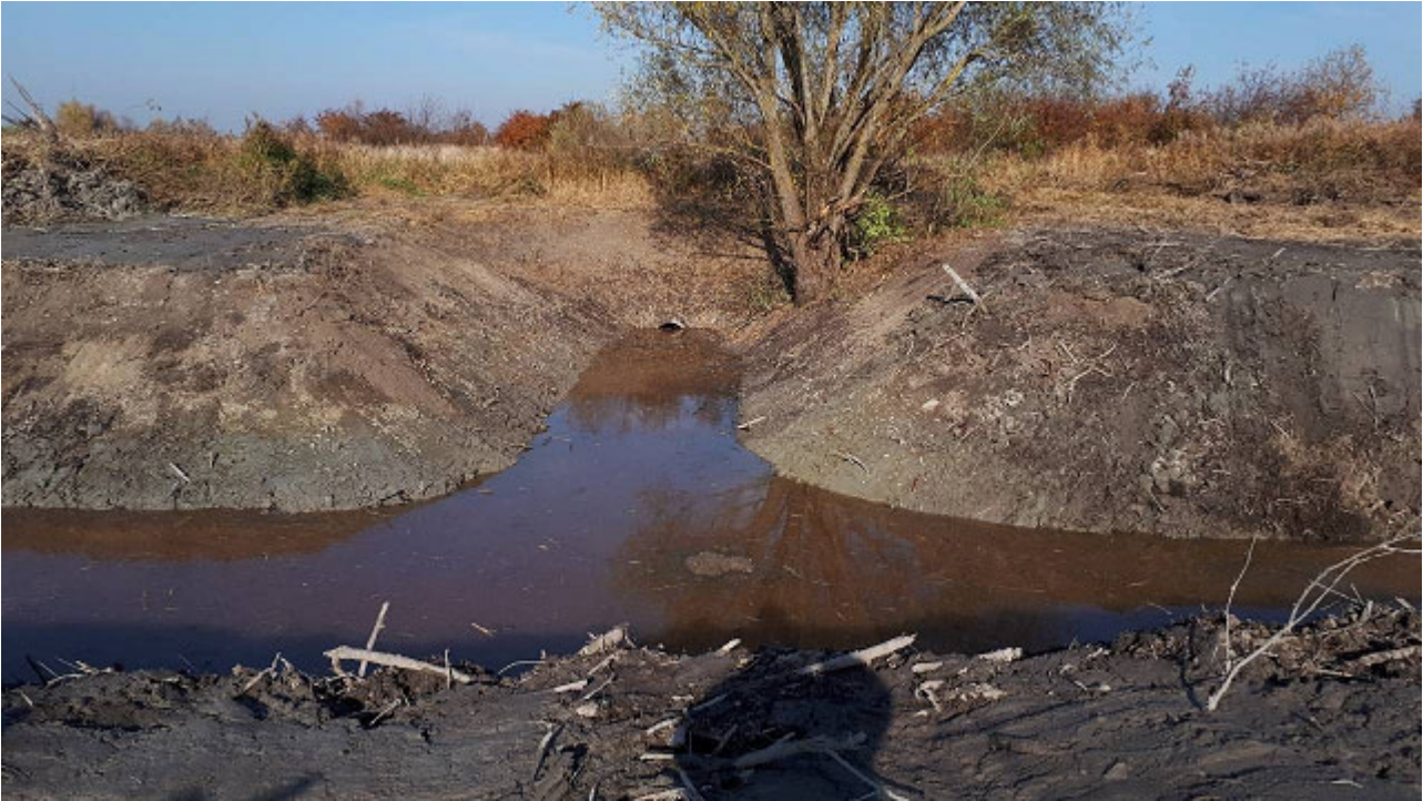
Рисунок 7 – Канал ТЖ-17 в районе трубопереезда после проведения ремонтных работ
