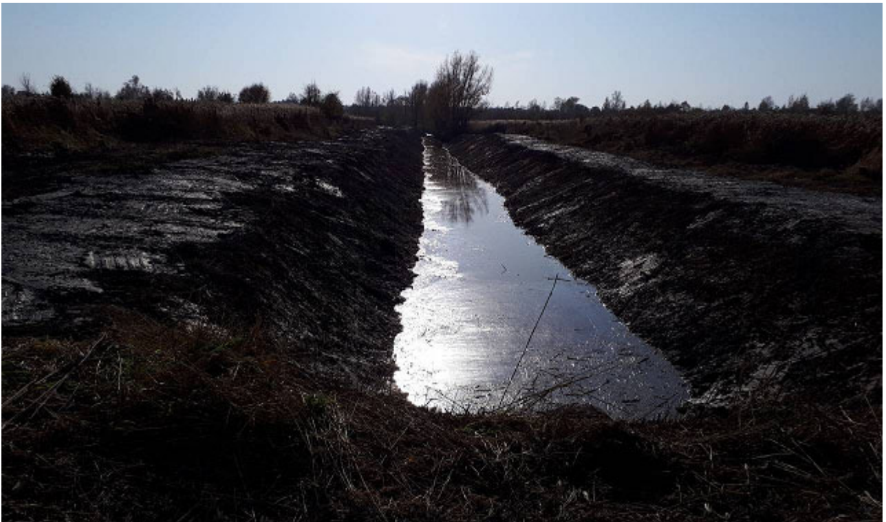
Рисунок 6 – Расположение кавальеров по обе стороны канала
