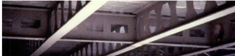
Рисунок 1 – Балка с прямоугольной перфорацией стенки
