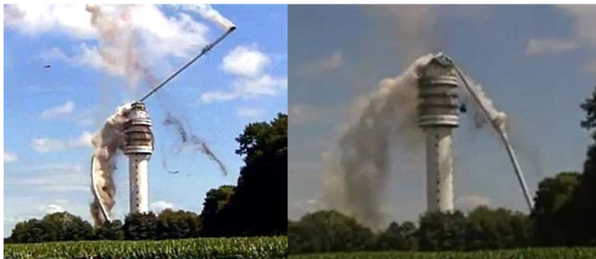
Рисунок 5 – Пожар на 300-метровой телебашне в городе Хогерсмилд
