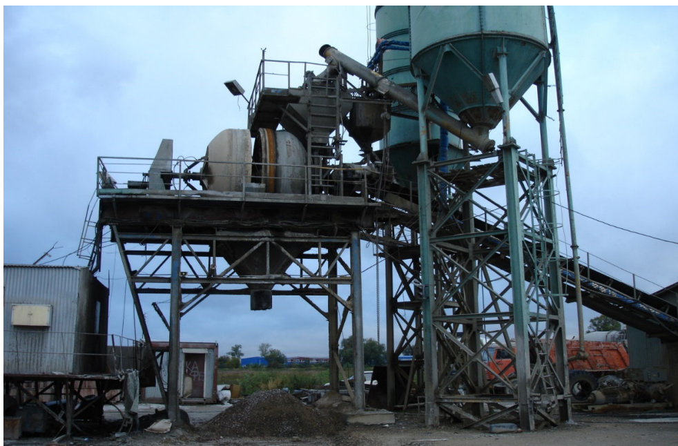
Рисунок 2 – Бетонный завод летнего исполнения
