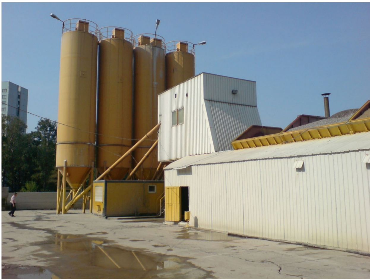
Рисунок 1 – Бетонный завод зимнего исполнения
