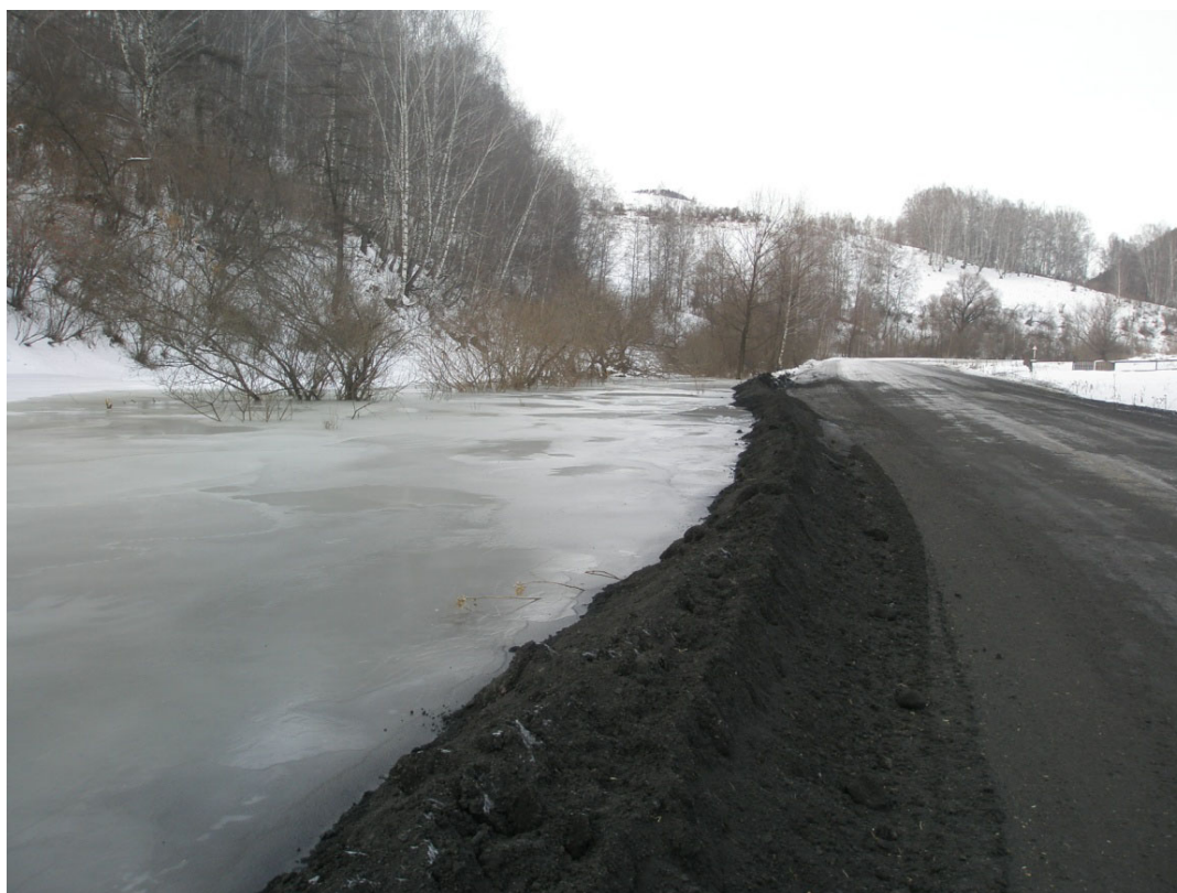
Рисунок 2 – Устройство грунтового вала из шлака вдоль участка наледообразования
